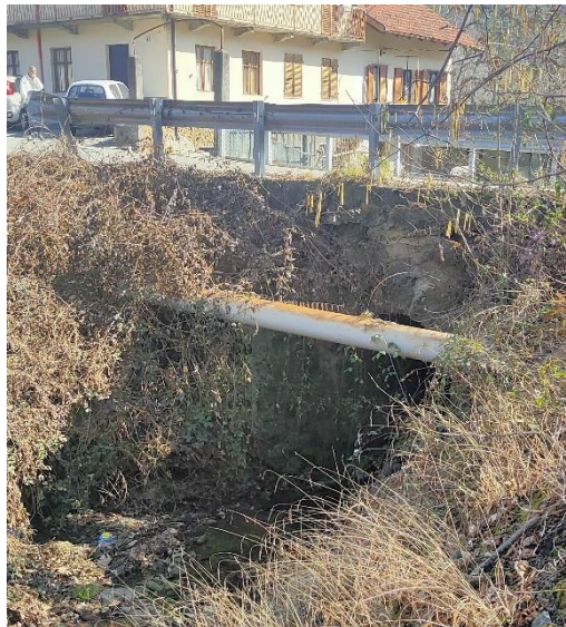
Attraversamento codice 26 schede SICOD in località Pian Bausano
