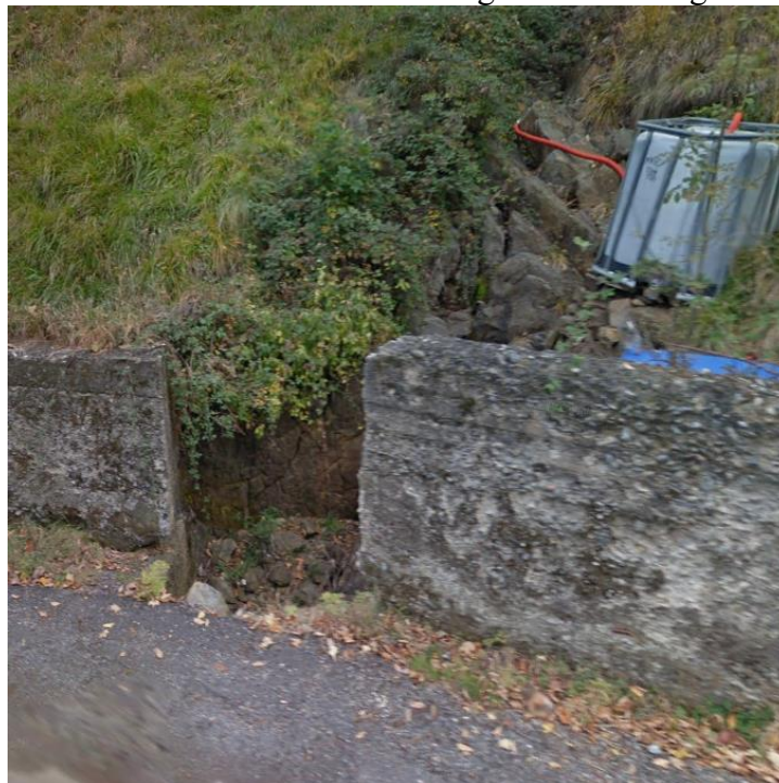
Attraversamento codice 72 schede SICOD lungo strada Castagnole – Cobeltramo
