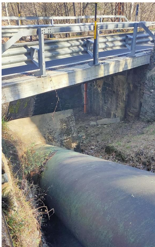
Attraversamento codice 33 schede SICOD in località Pian Bausano
