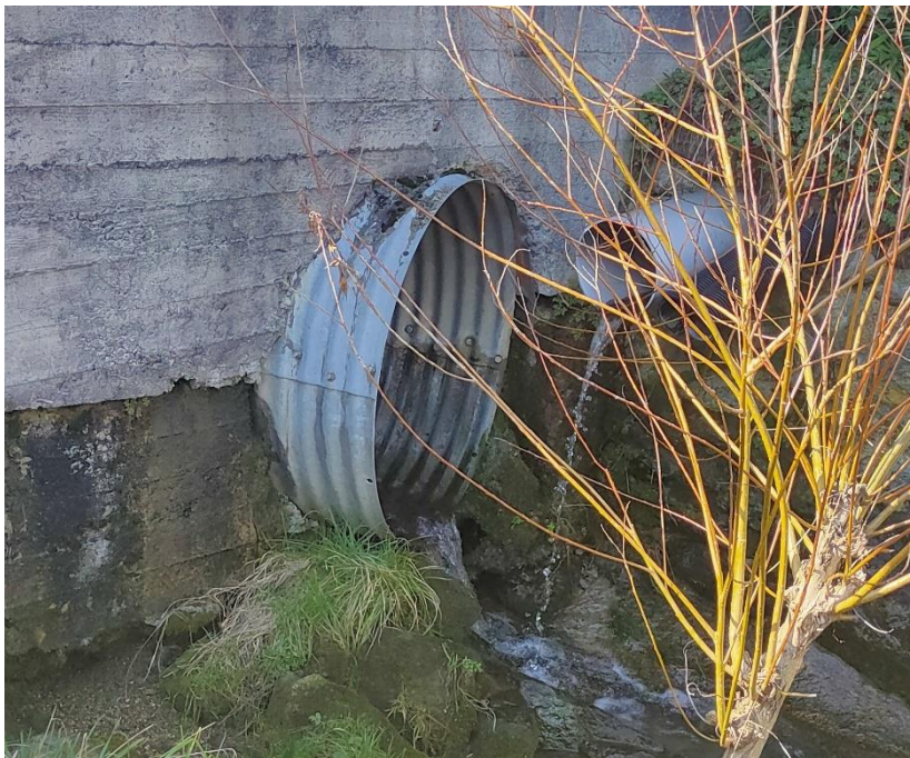
Attraversamento codice 73 schede SICOD in località Pian Bausano
