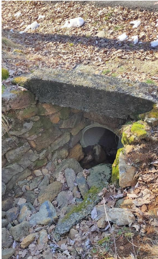
Attraversamento codice 20 schede SICOD lungo la strada tra Gias e Castagnole
