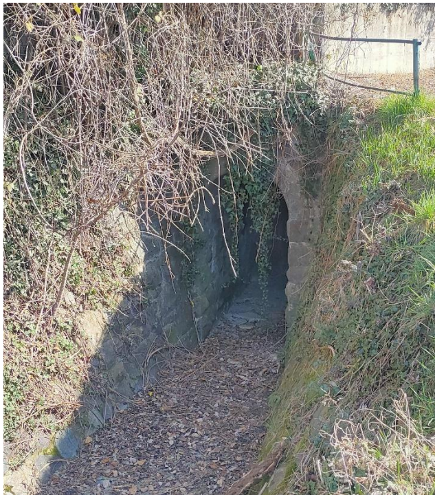
Attraversamento codice 59 schede SICOD nei pressi della centrale idroelettrica di Funghera
