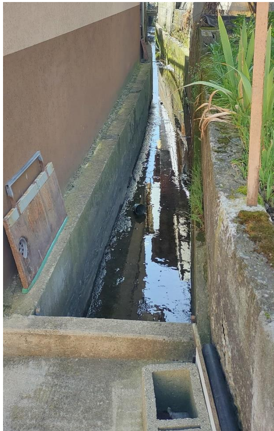
Canalizzazione codice 47 schede SICOD nei pressi del municipio di Germagnano
